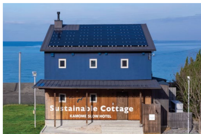
年間で使用する住宅エネルギーを概ねゼロにする未来型ハウス(S-ZEHモデルハウス) KAMOME SLOW HOTEL Sustainable Cottage
